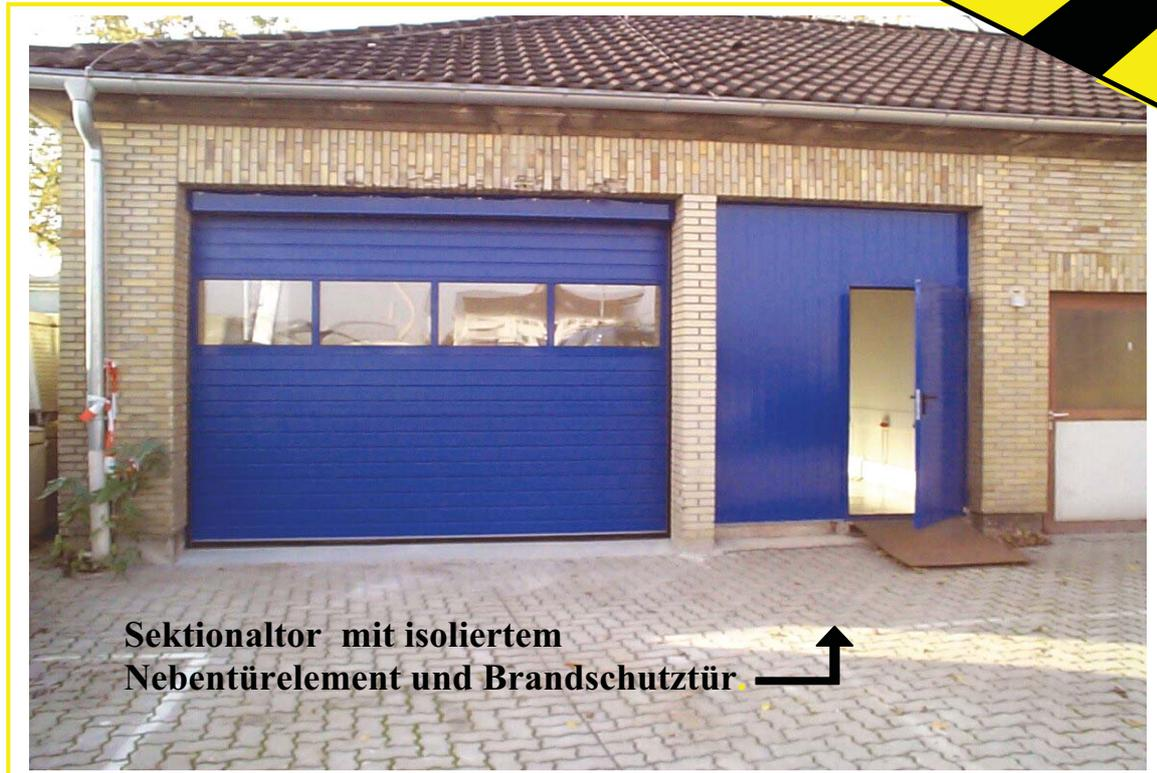
Sektionaltor mit isoliertem Nebentürelement und Brandschutztür. ↗
