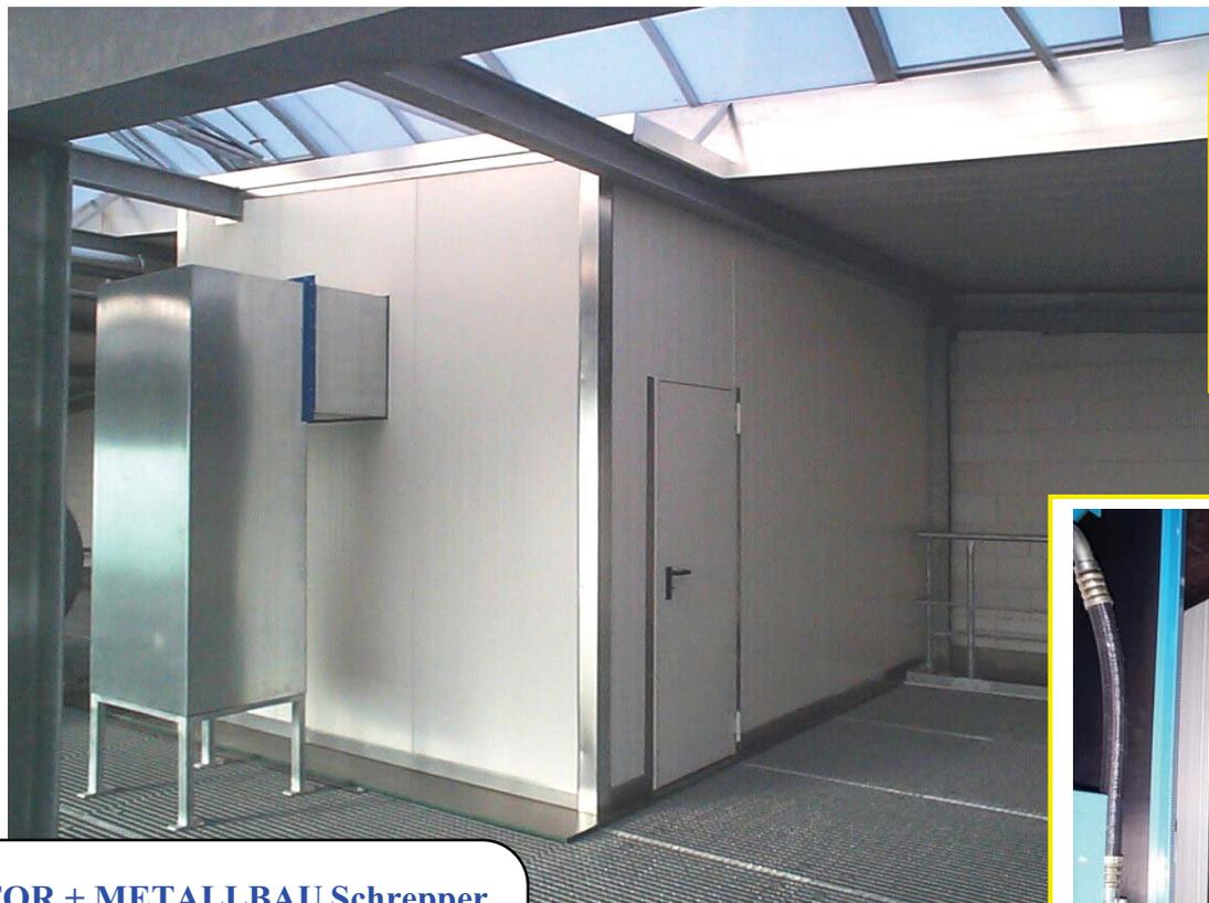
Schallschutzumhausung für oben gezeigten Kompressor mit eingelassener Brandschutztür.
