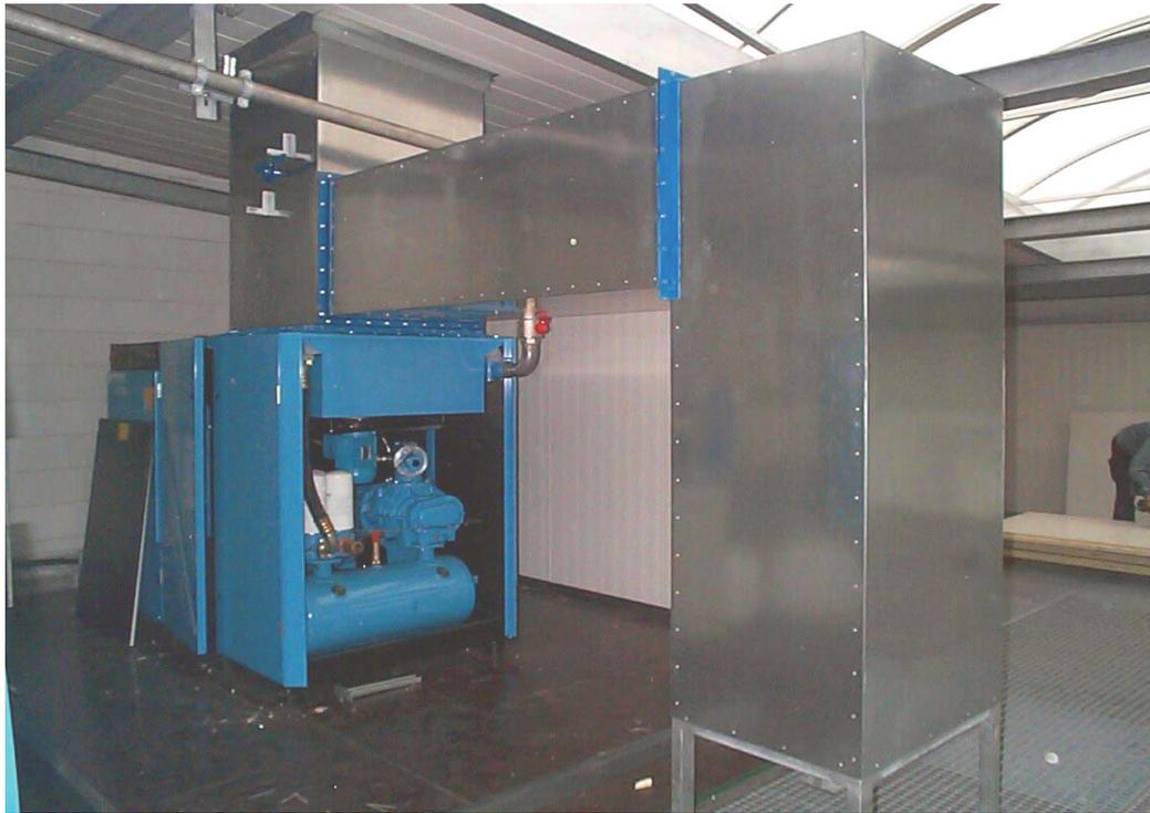
Herstellung eines Abluftkanals inkl. Dachdurchdringung für einen Schraubenkompressor.
