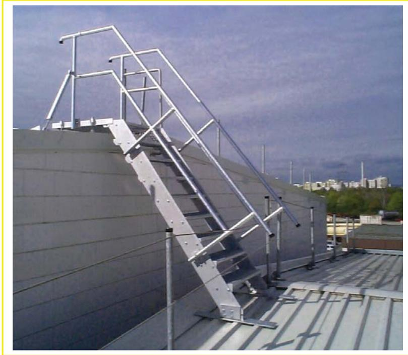
Treppenanlage zur Überbrückung zweier Produktionshallen, der jeweiligen Dachneigung angepasst.
